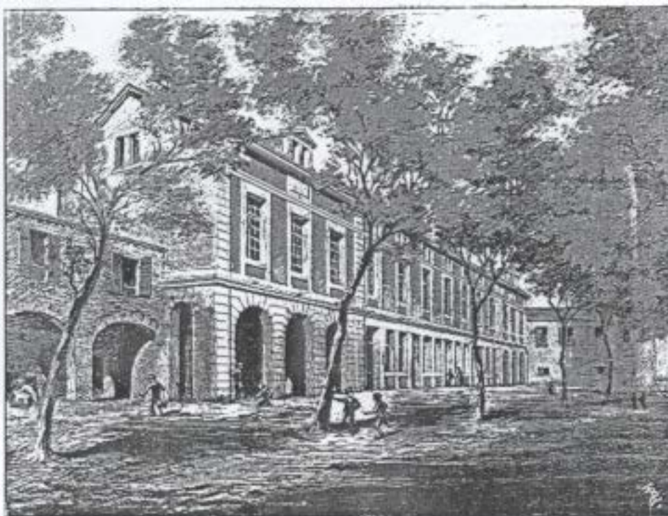
Cour de la colonie en 1893 après les travaux
